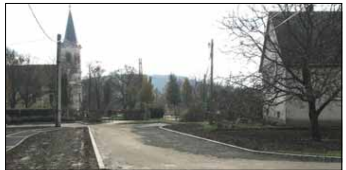
A Váci úti szilárd burkolatú gyalogjárda előkészületei
